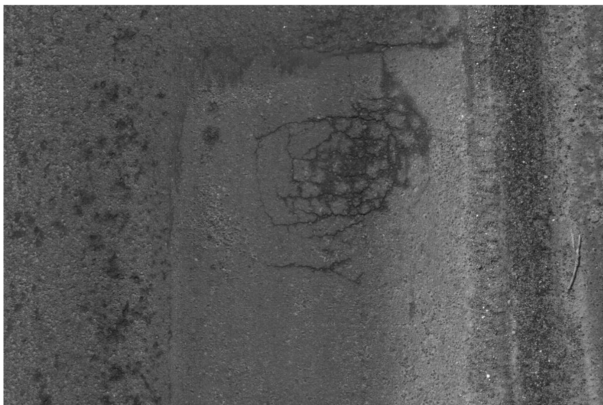
Fotografia 20 Spękanie siatkowe na łacie
